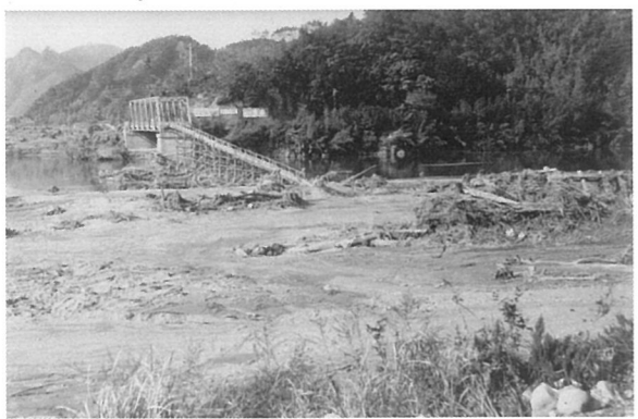
半分が流された大門橋。仮橋がかけられている。
