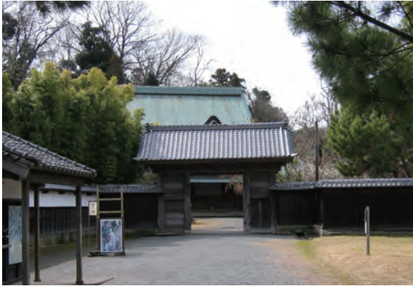
写真12 江川家住宅 表門
