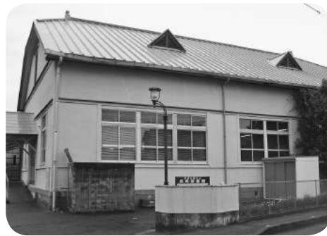
耐震性不足の長岡図書館
