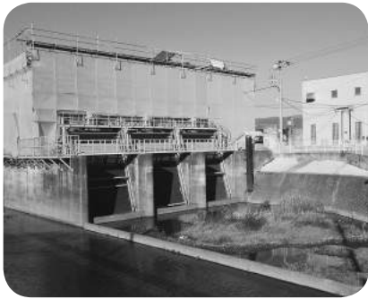
堂川排水機場
