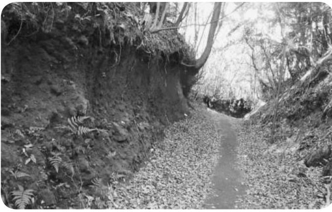
市道葦753号線の現状
