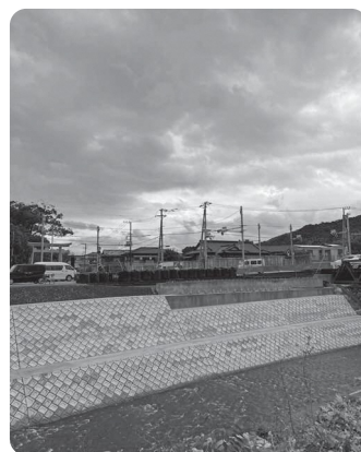
深沢橋架替事業 右岸下部工完成状況
