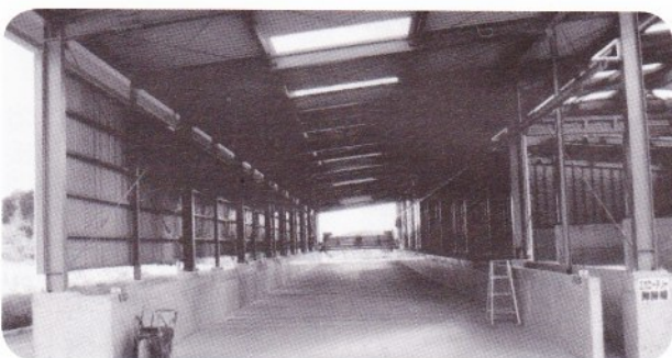
堆肥化施設・農土香 (浮橋)
