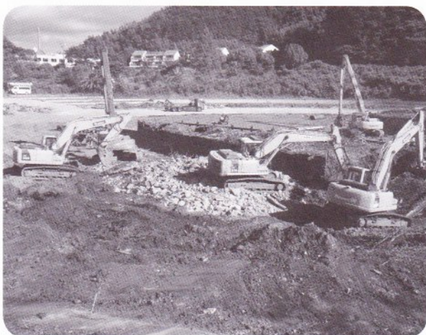
旧スポーツワールド跡地整地作業
