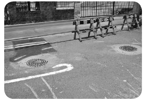
解体予定の防火水槽(南條)
