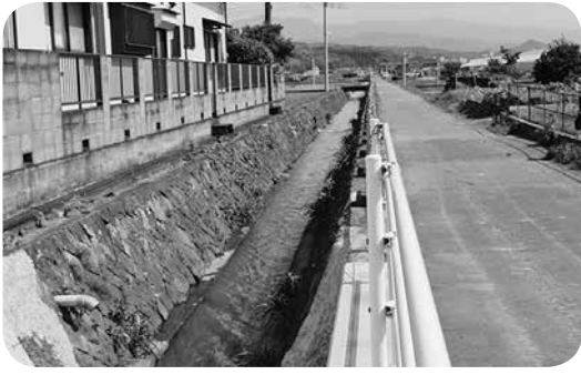
洞川カルバート部より上流の未工事部分
