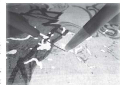
修理作業の様子
