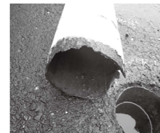
▲柱根元のさび(折れて倒壊するかも)
