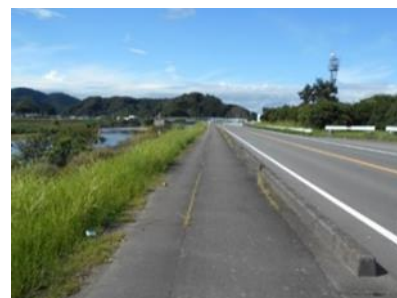
伊豆の国市内（国道414号）の「太平洋岸自転車道」 「県モデルルート（伊豆半島1周ルート）」
