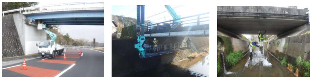
橋の定期点検状況
