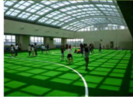
夏はプール、その他の季節は人工芝で覆われた屋上広場
