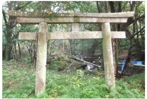
上水道鳴沢水源
