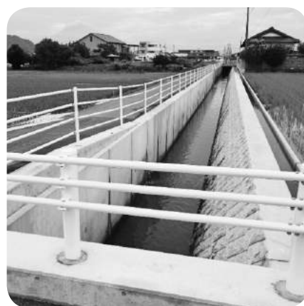
改修工事で完成した洞川の一部(四日町)
