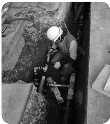
温泉管敷 ふせう 替え工事
