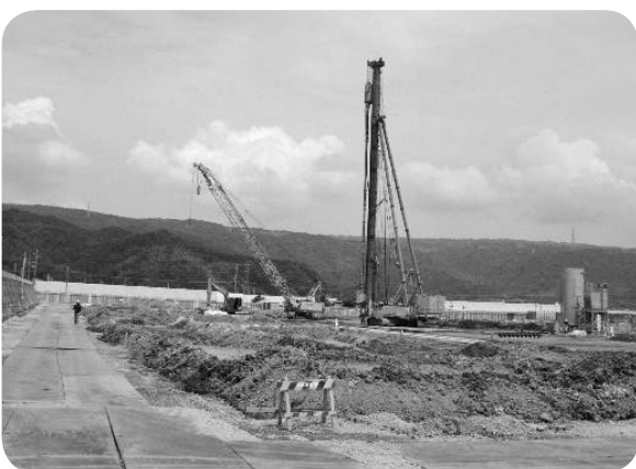
建設中の静岡県東部特別支援学校
