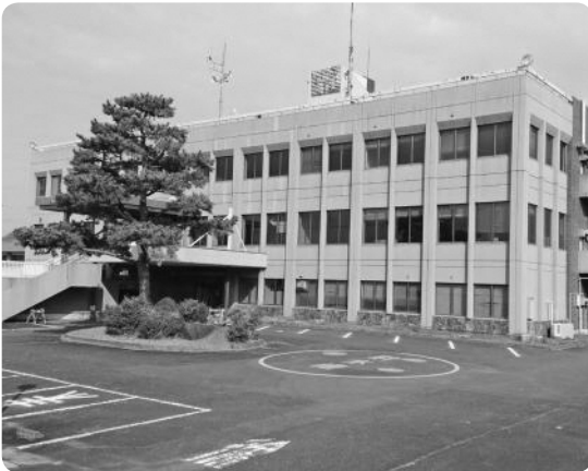
解体後 JA に売却予定の旧韮山庁舎
