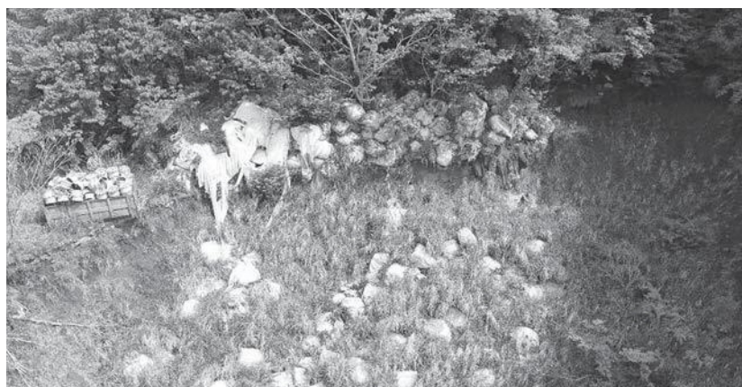
浮橋安野地区の山腹崩壊
