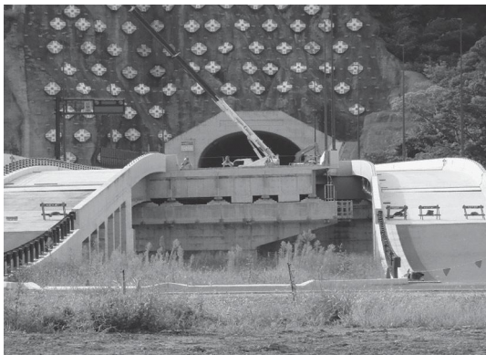
静岡バイパス大平IC付近 (令和4年9月撮影)
