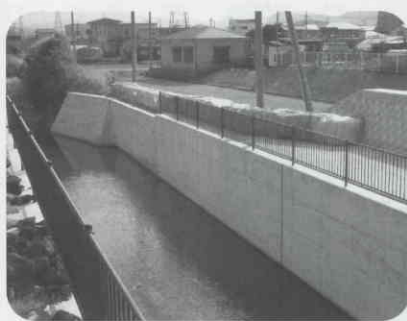
堂川堤防の状況
