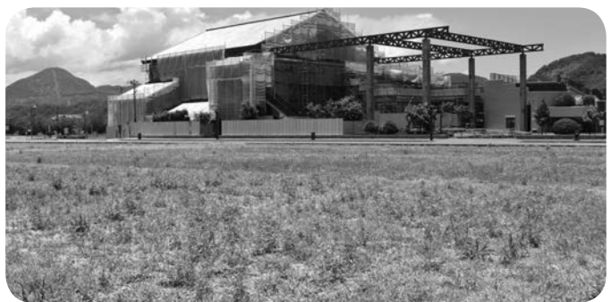
堀越保育園建設予定地
