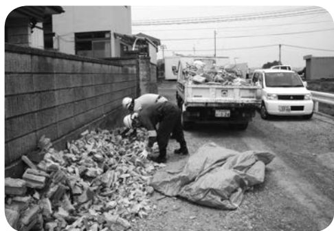
がれき撤去作業（多賀城市）
