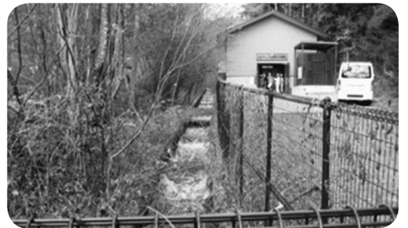
小水力発電施設（山梨県）
