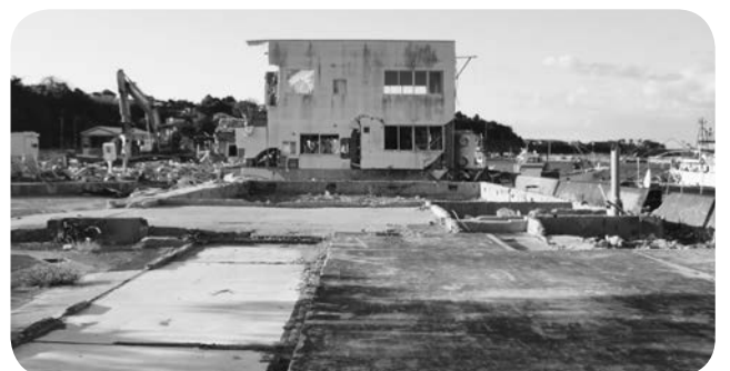
津波被害（多賀城市）
