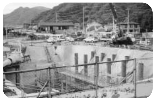
小坂排水機場増設工事
