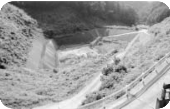
大仁一般廃棄物最終処分場
