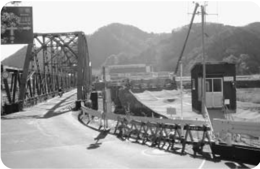
大仁橋架け替え工事
