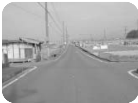
市道葦2-3号線（南条橋から北を望む）
