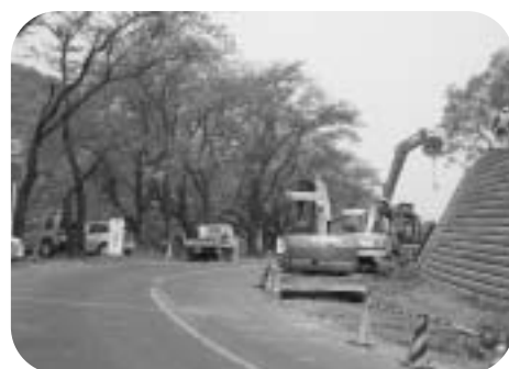
守山西公園整備
