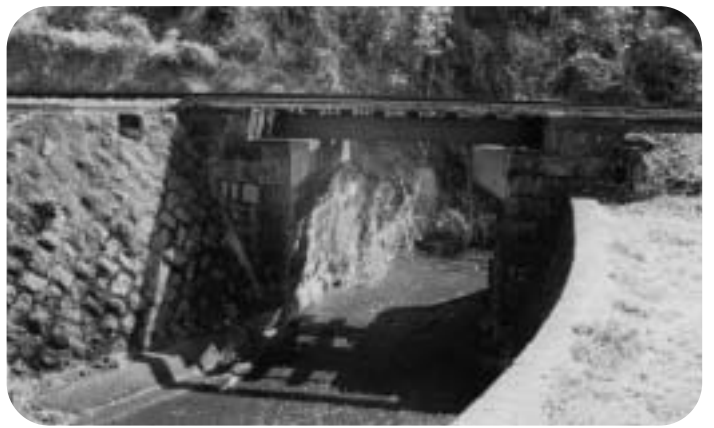
伊豆箱根鉄道鍋沢川鉄橋
