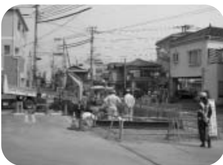
合併支援道路工事（古奈交差点）
