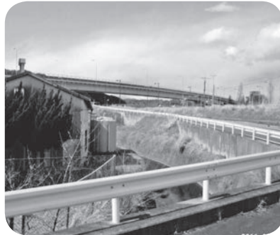
鍋沢川下流部排水ポンプ場予定地付近
