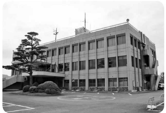
耐震性が心配される葦山支所
