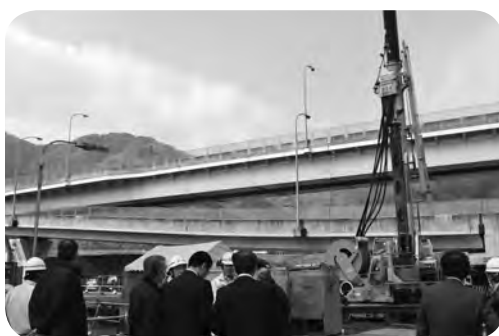
神島ポンプ場工事箇所
