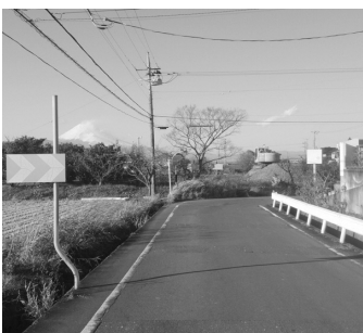
直進改良が望まれる 葦山中央農道の北端
