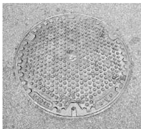
下水道マンホール
