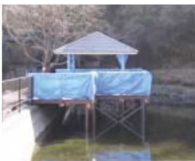
小坂の沢池に水上デッキ等を整備
