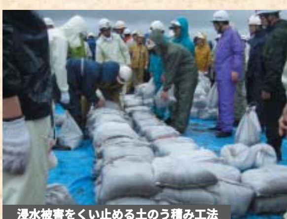
浸水被害をくい止める土のう積み工法
