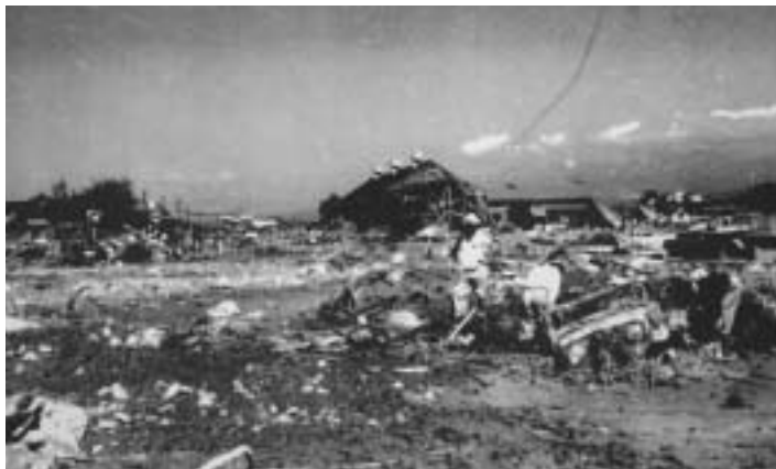
堤防決壊により家屋が跡形もなく流された南條付近
