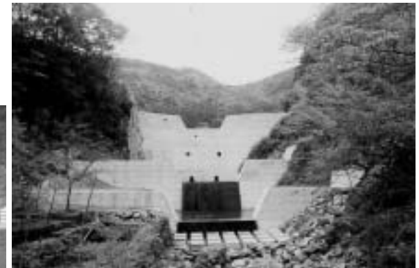
【上流部】狩野川台風の水害の根源となった山崩れや土石流をくい止めるため、上流部には数多くの砂防施設が作られました。写真は伊豆市の地藏堂第3砂防えん堤(上)と梅木第4砂防えん堤(左)
