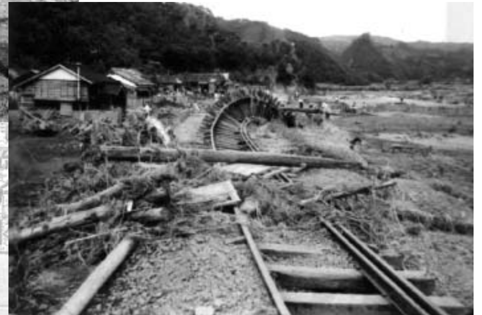
濁流の力であめのように曲がった大仁白坂付近の伊豆箱根鉄道駿豆線
