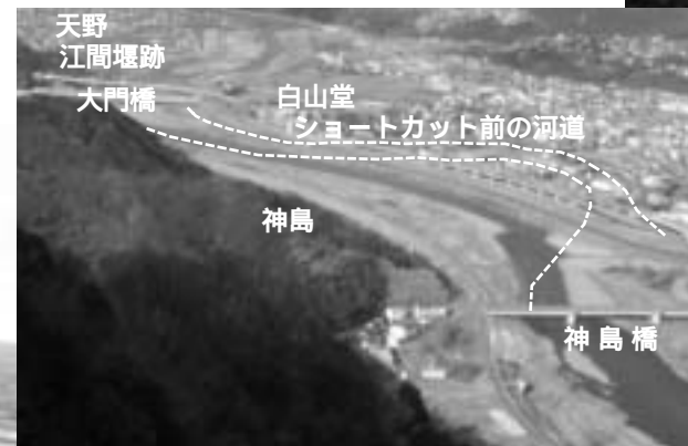
【中流部】台風以前よりも川幅が広げられ、頑丈になった大仁橋～大門橋付近の堤防(右) 蛇行した河道がショートカットされた白山堂・神島地区と江間堰が撤去された天野地区(下)
