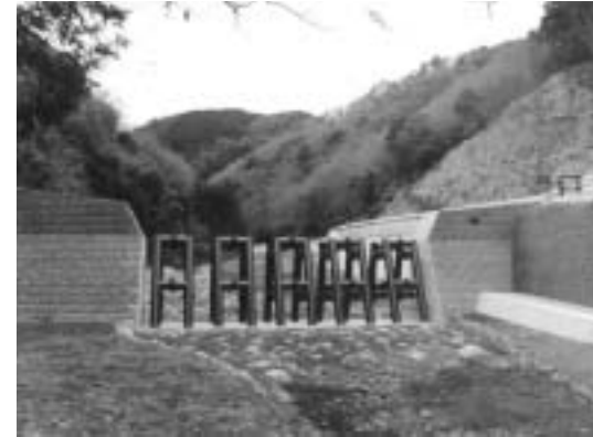
【上流部】狩野川台風の水害の根源となった山崩れや土石流をくい止めるため、上流部には数多くの砂防施設が作られました。写真は伊豆市の地藏堂第3砂防えん堤(上)と梅木第4砂防えん堤(左)
