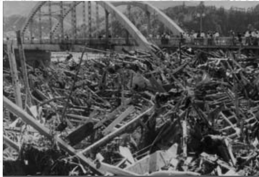
上流から千歳橋に流れ着き、山のように堆積した倒木や家屋の破片
