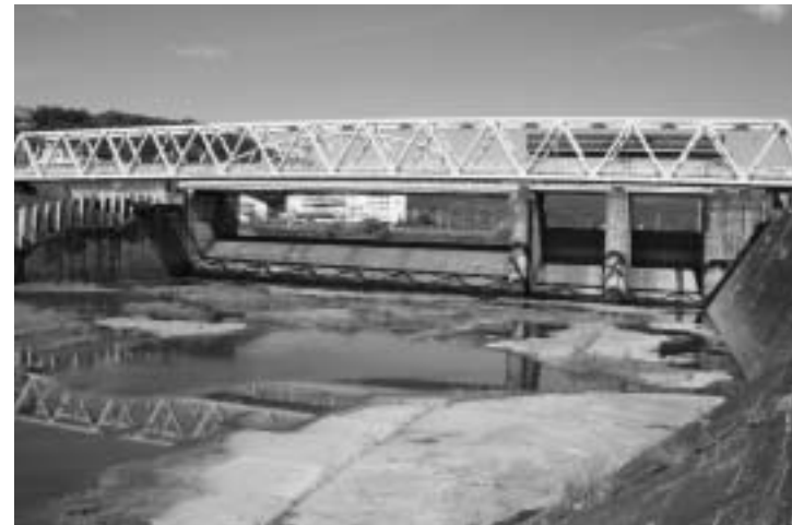
【狩野川放水路】狩野川台風以前の昭和25年から着工していた放水路も、台風の後、トンネルを2本から3本に増やし、断面も拡大するなど計画を大幅に変更しました。そして地元住民の理解や協力を得て、総延長2,980mの大水路は昭和40年に完成しました。
