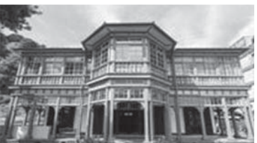
旧鹿児島紡績所技師館（異人館）
