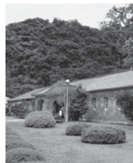
鹿児島市 旧集成館機械工場
