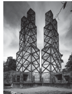
昭和32年の保存修理後の葦山反射炉
