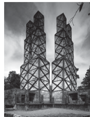
昭和32年の保存修理後の葦山反射炉
