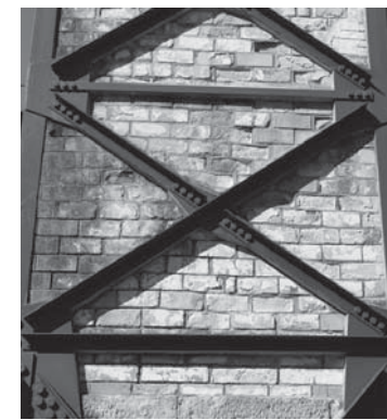
反射炉の煉瓦と鉄骨トラス
