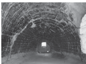
▲オリジナルと修復時に差し替えた煉瓦が混在する現在の反射炉 ◀外側とは異なり耐火煉瓦で覆われた炉内
