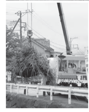
河川内に入り草刈り(上) 重機を用いて草を撤去(下)
