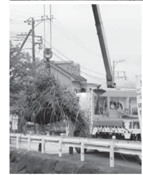
河川内に入り草刈り(上) 重機を用いて草を撤去(下)
