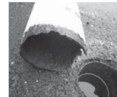
柱根元のさび（折れて倒壊するかも）
