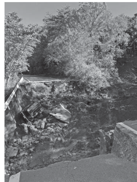
▲ 富士見パークウェイ(道路陥没)
