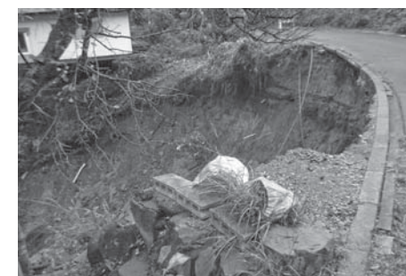
▲ 伊豆エメラルドタウン内(道路崩落)
