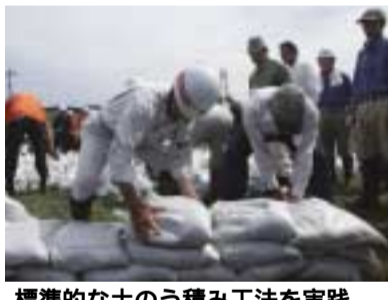
標準的な土のう積み工法を実践
