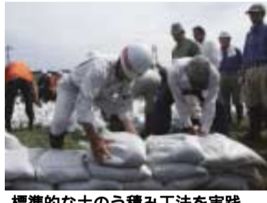
標準的な土のう積み工法を実践
