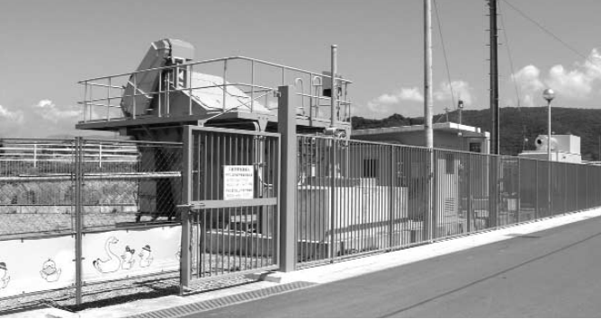
旭台排水機場を整備
