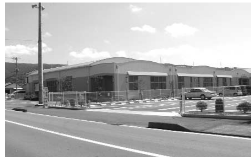
旧菰山町：北部(富士美)幼稚園の整備
