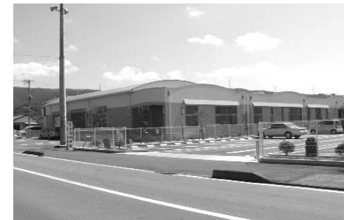
旧菰山町：北部（富士美）幼稚園の整備
