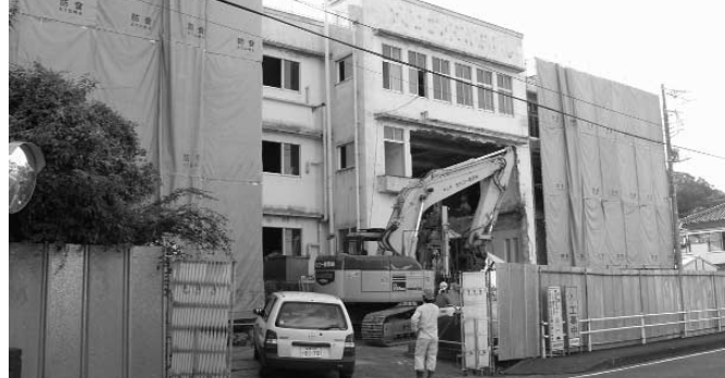
旧大観宮跡地を取得、現在、取り壊し工事中
