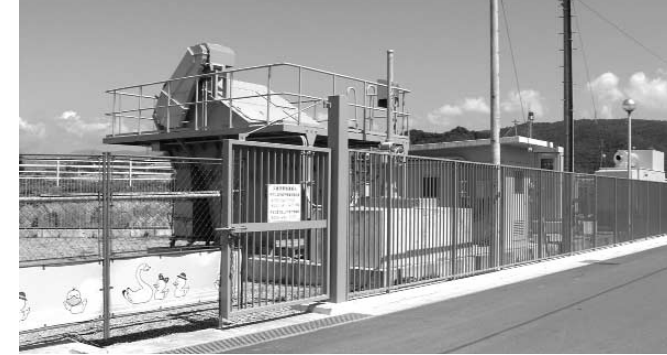
旭台排水機場を整備
