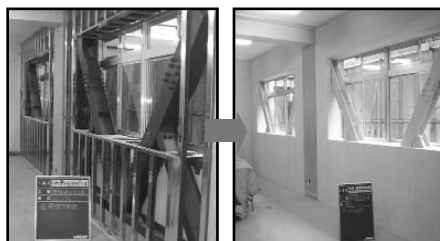
安心・安全な教育環境を目指し、校舎の耐震化を推進(写真は菰山南小学校)
