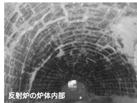
反射炉の炉体内部
