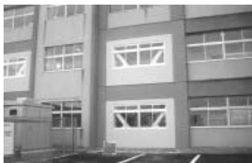
葦山南小耐震補強事業（中）
