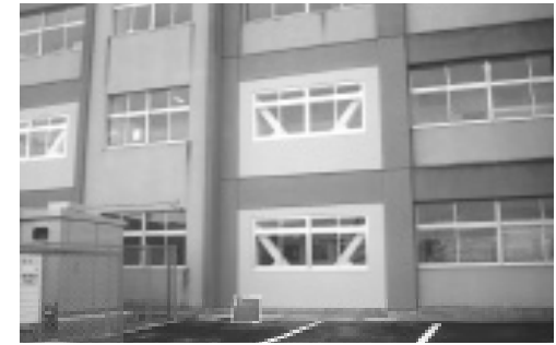
葦山南小耐震補強事業(中)
